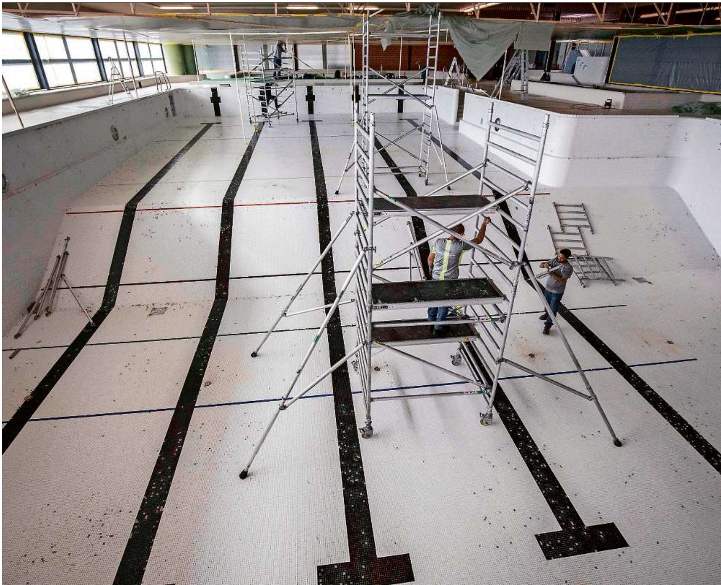
Vorbereitungsarbeiten: Im Hallenbad der Lintharena wird die Decke mit Kunststofffolien geschützt.
