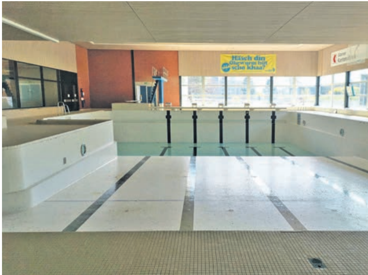
Hallenbad lintharena sgu: Der Stöpsel ist gezogen, die Sanierung beginnt.
