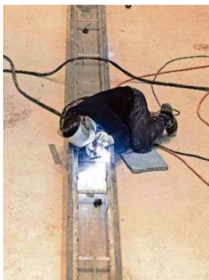
Täglich bis zu 20 Unternehmen auf der Baustelle: Im Innern der Rutschbahn werden die Fugen ausgespachtelt (oben), der Beckenboden wird verschweisst (Mitte), und die Planschbecken warten auf die Plättlileger.
